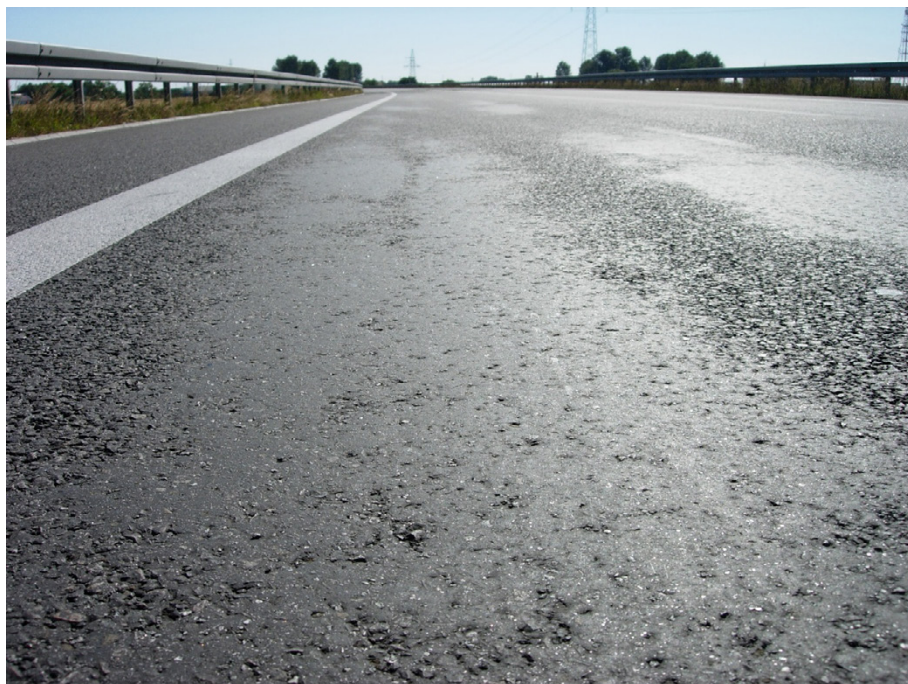
Rys. Z1.1. Plamy na powierzchni SMA spowodowane brakiem stabilizatora lub jego nieskutecznym działaniem (fot. K. Błażejowski)
