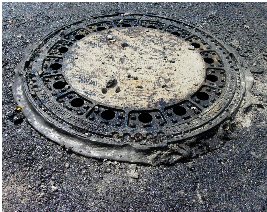
Rys. 6.1. Taśma asfaltowo-polimerowa do uszczelniania spoin w nawierzchni przyklejona do krawędzi wjazdu (fot. K. Błażejowski)
