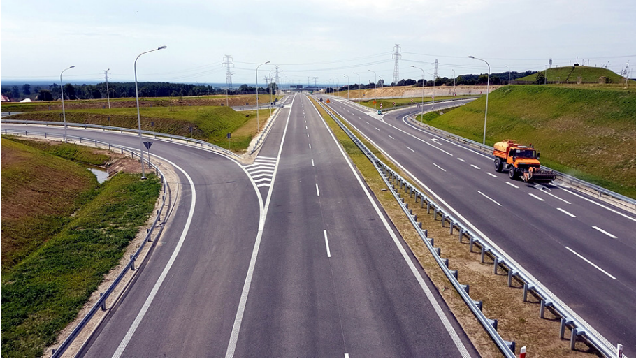
Rys. 7.4. Widok nawierzchni SMA 16 i SMA 11, obwodnica Ostrowa Wlkp. (fot. B. Bogdański)
