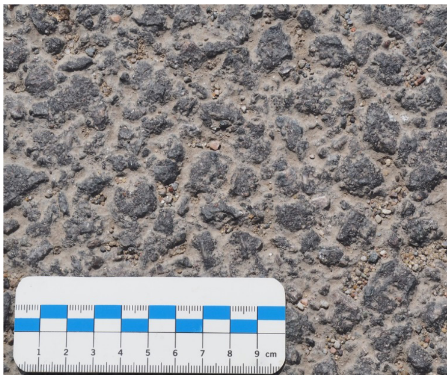
Rys. 3.5. Struktura powierzchni warstwy z SMA 16 JENA (fot. Krzysztof Błażejowski)
