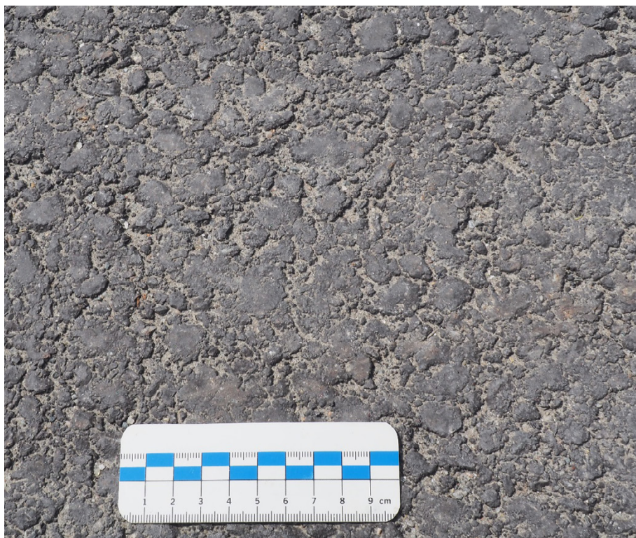
Rys. 6.2. Widok gotowej warstwy z SMA16 JENA po wbudowaniu (fot. K. Błażejowski)
