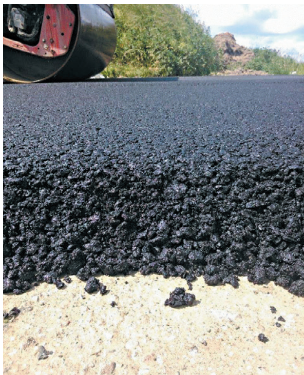
nawierzchnia w jednej warstwie
