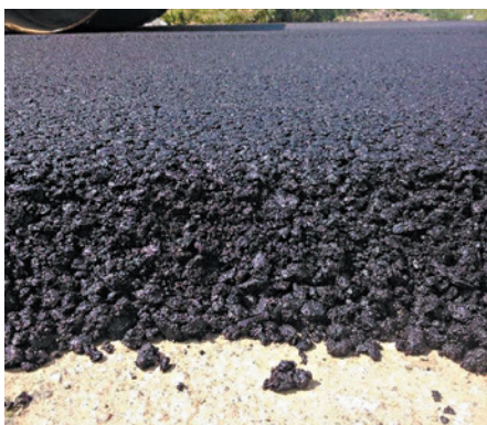
nawierzchnia w jednej warstwie
