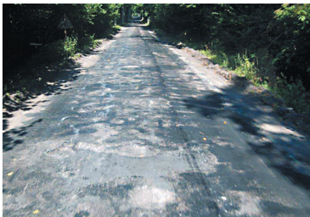
droga przed modernizacją...
